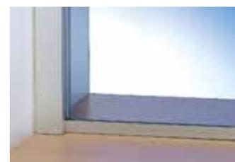
Zarge mit feststehendem Seitenteil und U-Profil im Boden.
